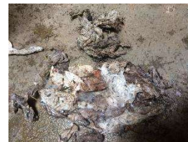
Abfälle aus dem Pumpwerk Fraumatt (z. B. Bodenwischmopp)
