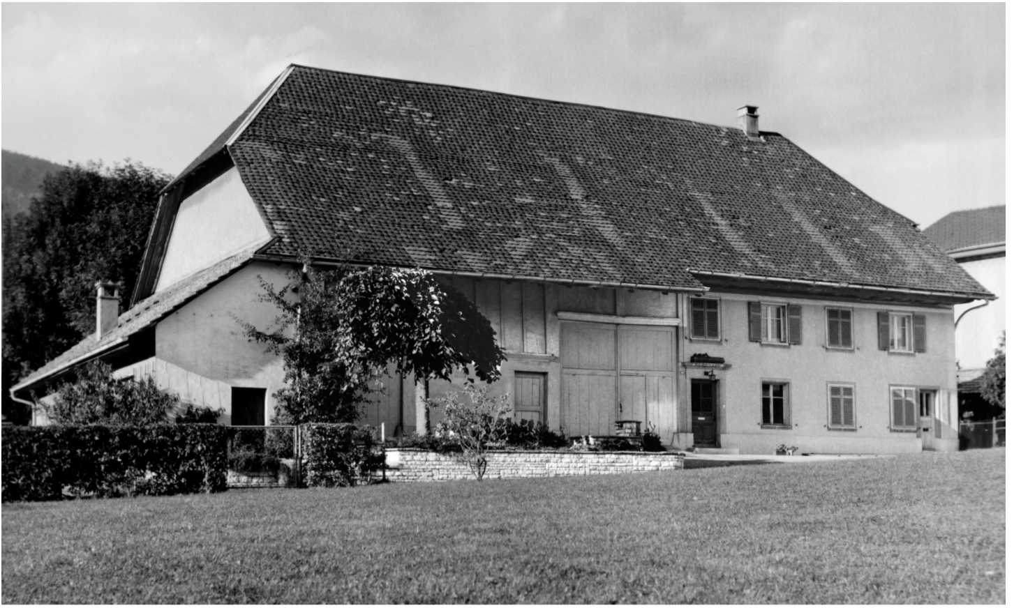
Verwaltungsgebäude Selzach vor Umbau
